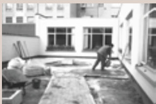
Les ouvriers du STIC rénovent la cour de la bibliothèque communale
